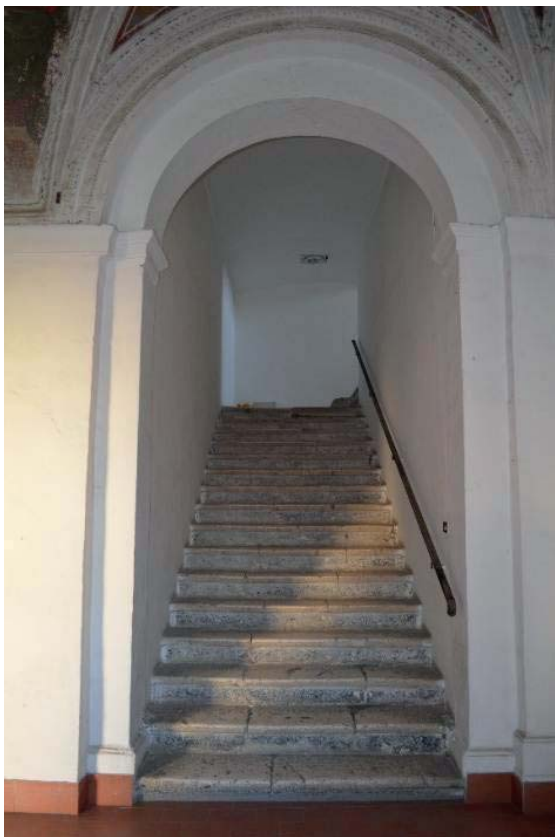
28. Caserta, Palazzo al Boschetto - Atrio delle Scienze e Virtù. La scala che conduce al piano nobile
