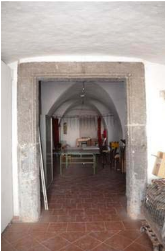
83. 84. Caserta, San Leucio, Belvedere - ingresso ai locali al piano terra e portale squadrato in piperno
