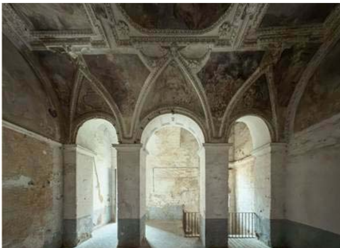
41. Caserta, Palazzo al Boschetto - Sala di Giuditta e Oloferne e di Davide e Golia - (a destra) la scala di accesso ai locali seminterrati destinati da depositi e cucine
