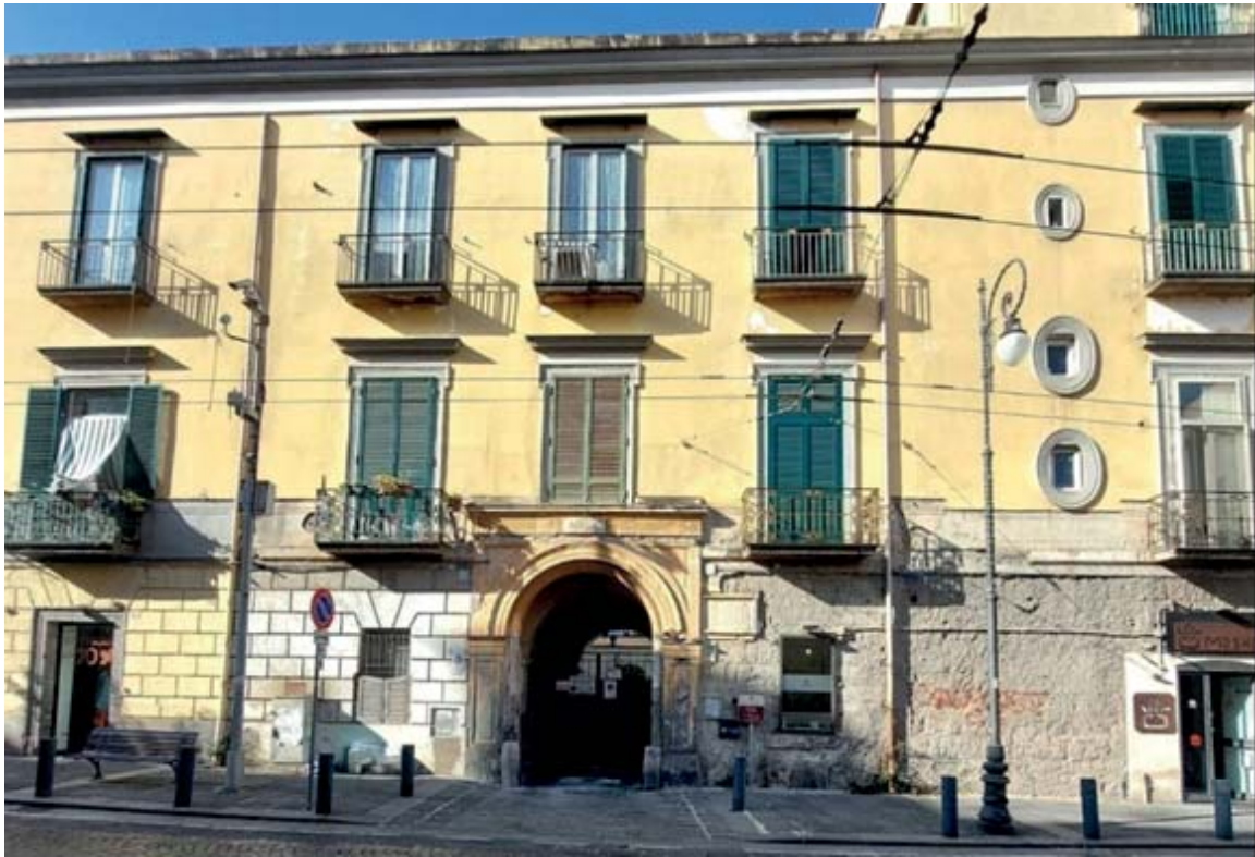
2. Portici (Napoli), Villa Nava - prospetto su Corso Garibaldi n. 239 (© Google Maps)
